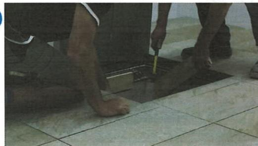
Odstráňte krytky skrutiek, pomocou priložených kľúčov otvorte poklop a zaistite pred možným zaklopením ! Potom odstráňte debnenie. Opäť vyčistíte viditeľné časti, ktoré sú znečistené po betonáži.
