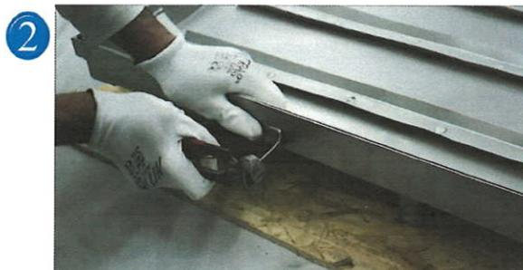
2 Ohnite navarené kotvy pod uhlom min. 45°, aby neskôr boli spoľahlivo pevne zaliate v betóne.
