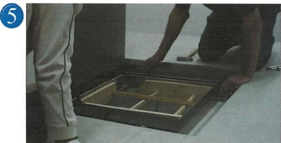
5 Otvorte šachtový poklop pomocou zdvíhacích kľúčov, zaistíte pomocou západky a pripravte vnútorné debnenie rámu.
