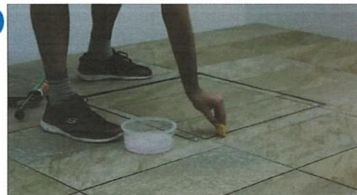
Zatvorte podlahový poklop, zaskrutkujte skrutky a nasadte krytky. Kľúče k otvoreniu poklopu si bezpečne odložte.
